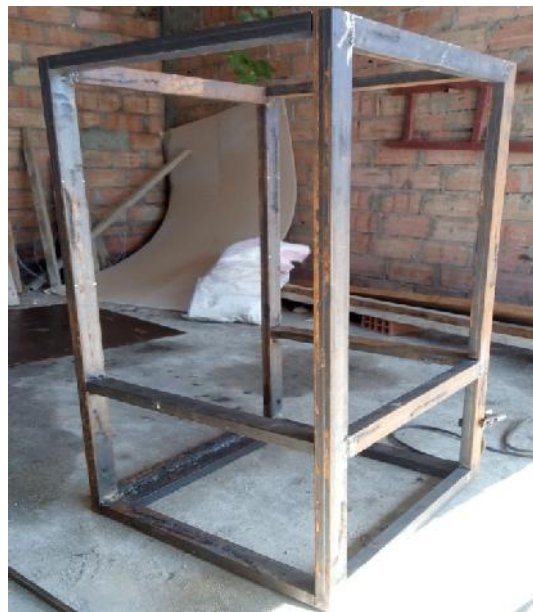
Figure IV.4: ossature métallique du four
