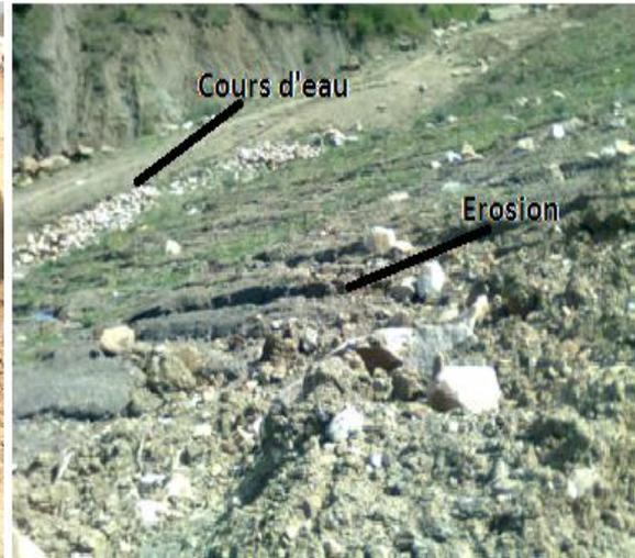
**Figure (V-19) :** L'érosion de la pente.
