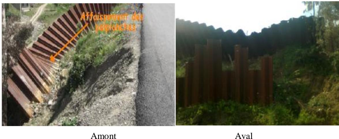
**Figure (V-12) :** Affaissement des palplanches.
