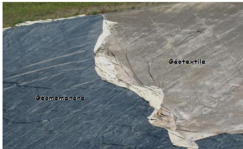
**Figure (V-32) :** Arrachement du géotextile.
