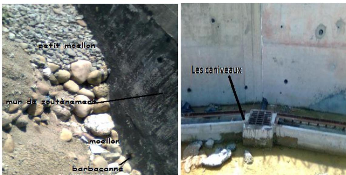
Figure (V-25) : Système de drainage en amont et en aval du mur de soutènement.
