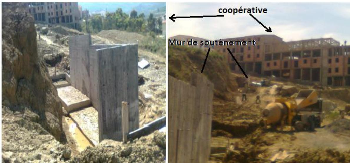
**Figure (V-17) :** Réalisation d'un mur de soutènement à gauche de la coopérative
