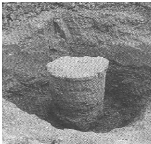
**Figure (IV-38) :** Colonnes de sol traité à la chaux.
