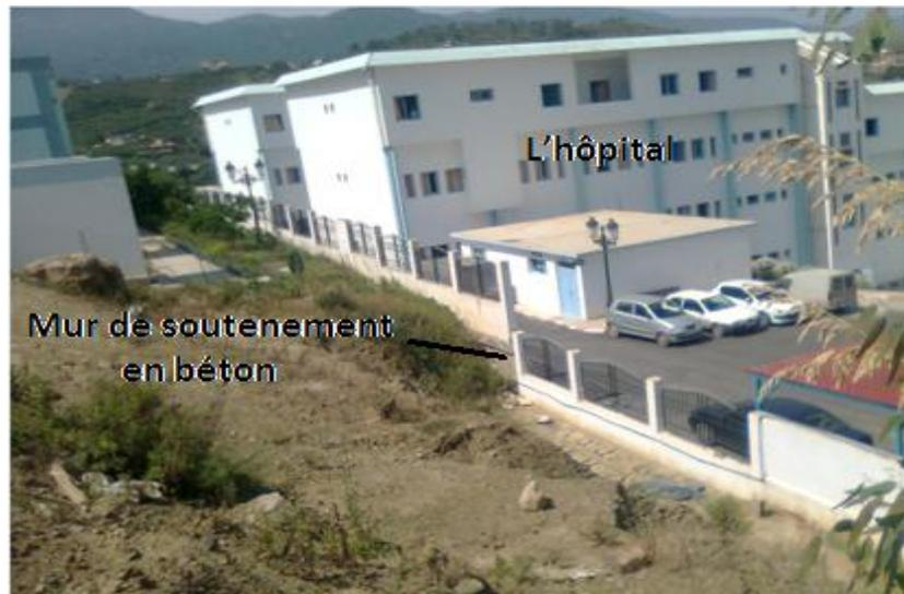
**Figure (V-16) :** Réalisation d'un mur de soutènement en amont de l'hôpital (Aval de la coopérative).
