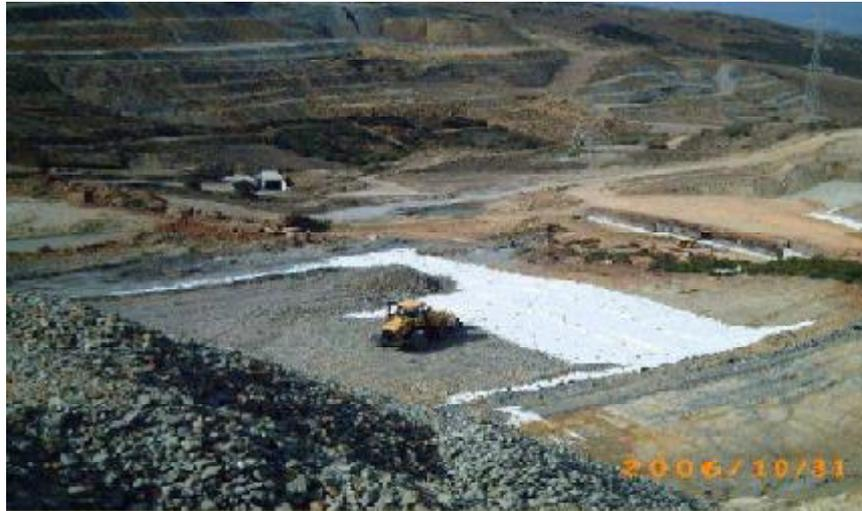
**Figure (V-38) :** Mise en place des matériaux drainant pour bêche d'ancrage.
