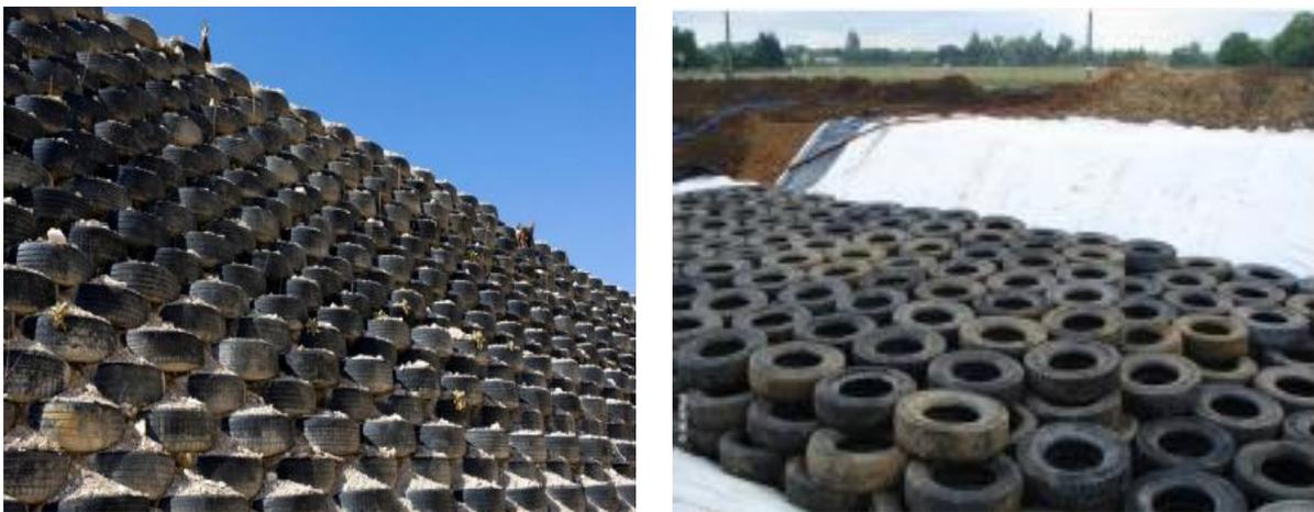
**Figure (IV-36) :** Procédé de renforcement de remblai par pneus.
