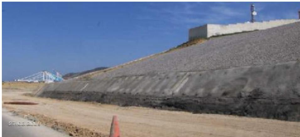
**Figure (V-39) :** Déblai traité par clouage et béton projeté.
