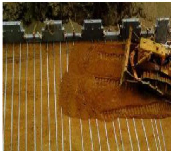
**Figure (IV – 23):** Constitution d'un mur en Terre Armée.
