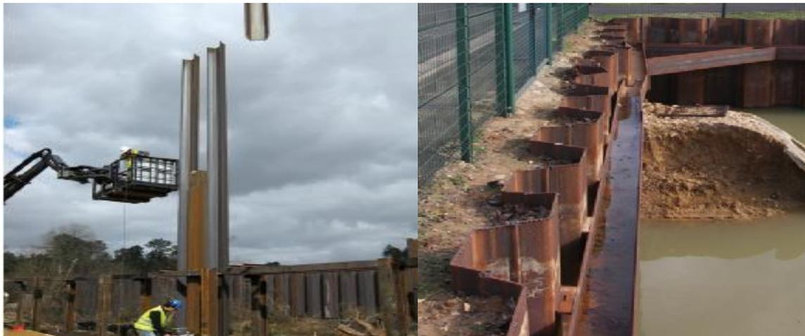
Figure (IV – 22): Réalisation de rideaux de palplanches.
