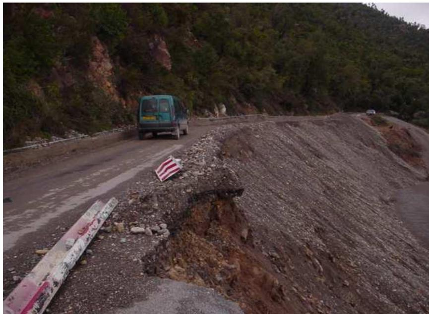
Figure (V-1) : La chaussée affectée par le glissement.
