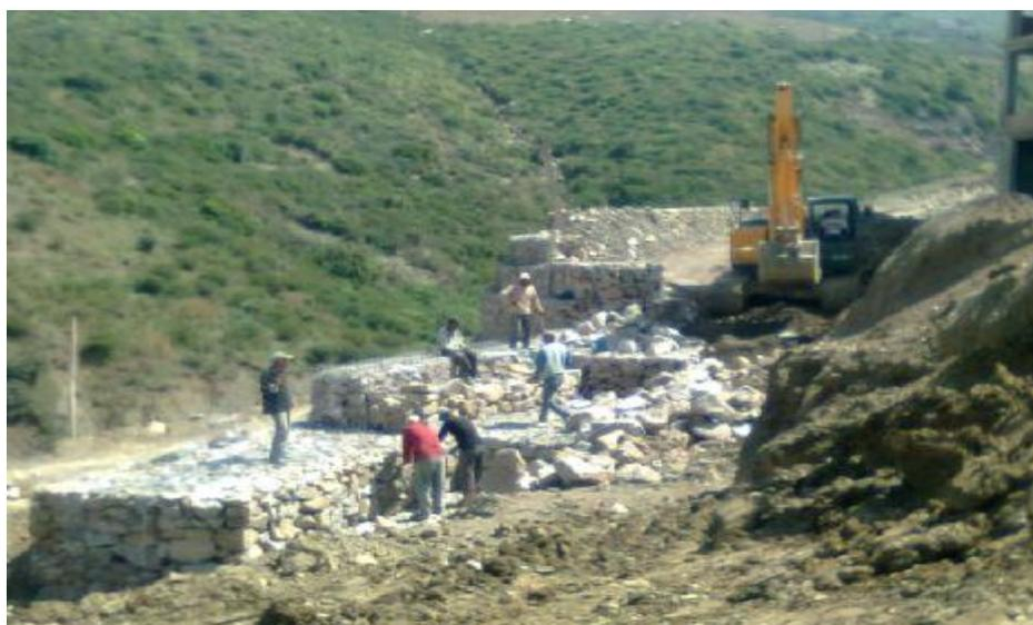
**Figure (V-15) :** Travaux de réalisation du mur en gabion.
