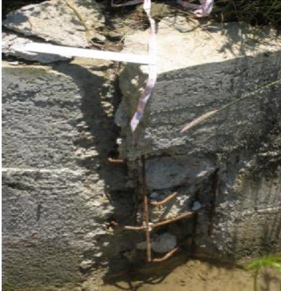
**Figure (V-29) :** Cisaillement des caniveaux et arrachement des aciers .
