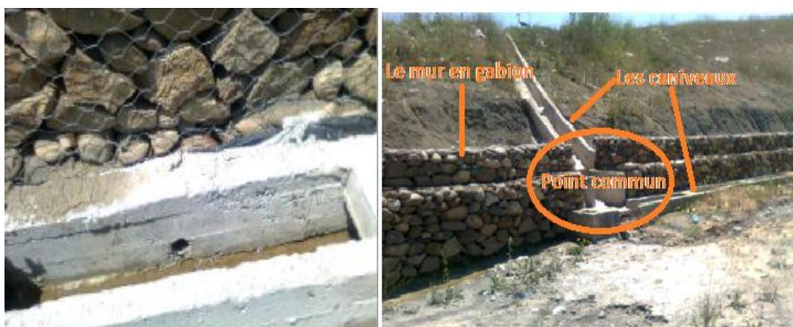
**Figure (V-23) :** Caniveaux à l'aval du mur en gabion et le point commun entre eux.
