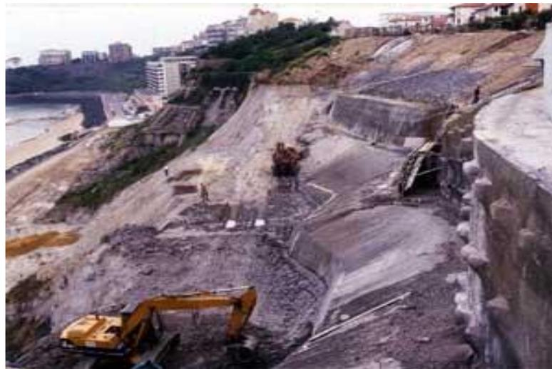
**Figure (IV-1) :** Phase terrassement pour stabilisation d'une pente.
