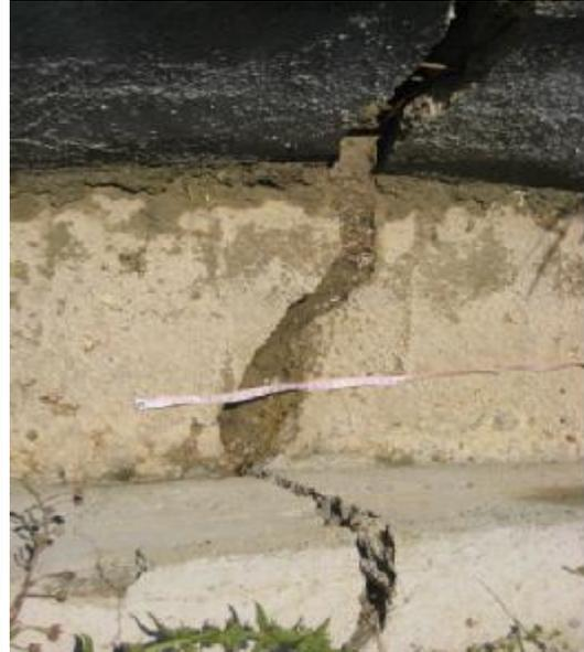
**Figure (V-30) :** Circulation d'eau dans les fissures.
