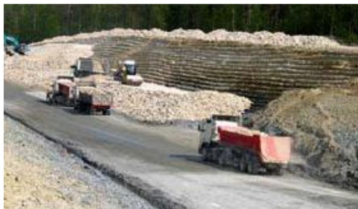
**Figure (IV-10) :** Réalisation d'un masque.
