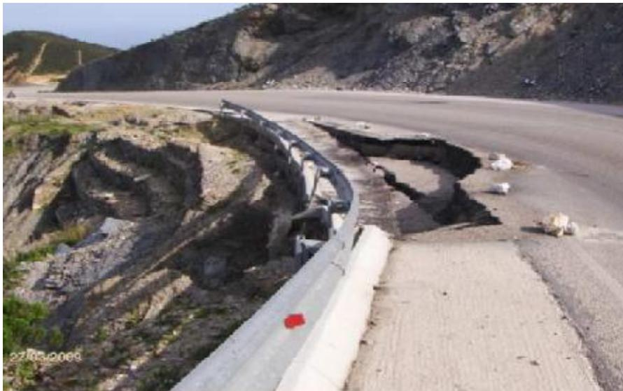
Figure (V-34) : Dégradation du remblai RN16
