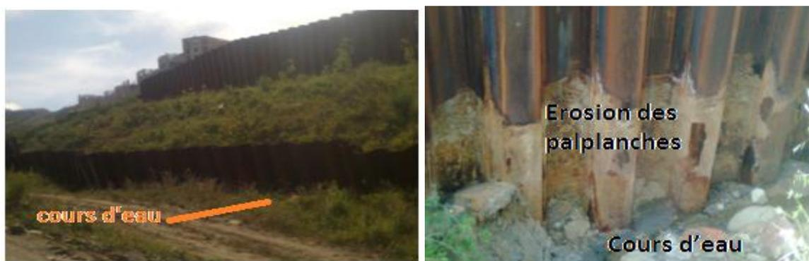
**Figure (V-13) :** Les deux rangées de palplanches et leur érosion.
