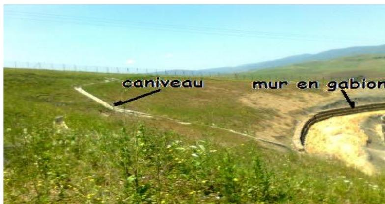
**Figure (V-22) :** Système de drainage de la partie supérieure.
