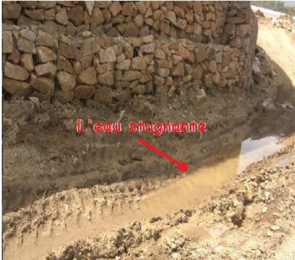
**Figure (V-18) :** L'eau stagnante à l'aval du mur en gabion.
