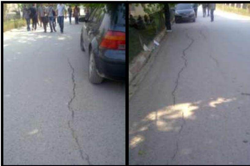
**Fig. III.32: Fissures longitudinales parallèles à l'axe de chaussée.**
