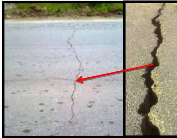
**Fig.III.33: Fissures transversales perpendiculaires à l'axe de chaussée. RN 71 (IRSANE)**
