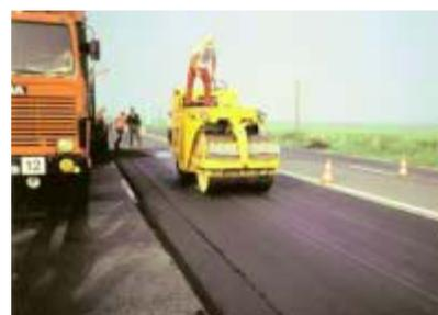
**Fig. VII. 10 : Compactage du sable enrobé Anti-fissure [STBA-1999]**
