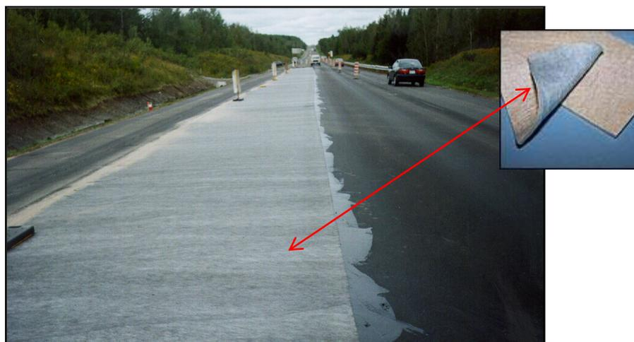
Fig. V.II.16 : Géotextile imprégné de bitume. [Bozkurt et al. (RILEM 2000)]
