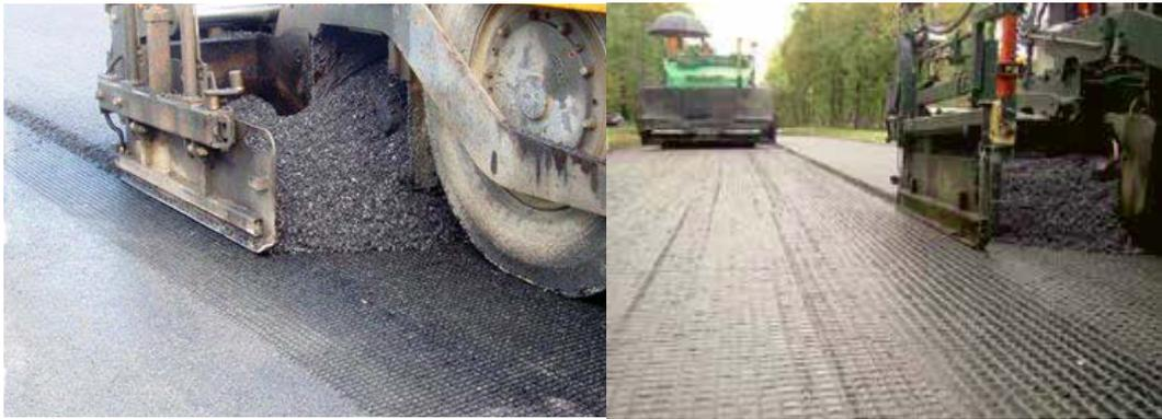
**Fig. V.II.20 : l'interposition de la géogrille. [MACCAFERRI 2012]**
