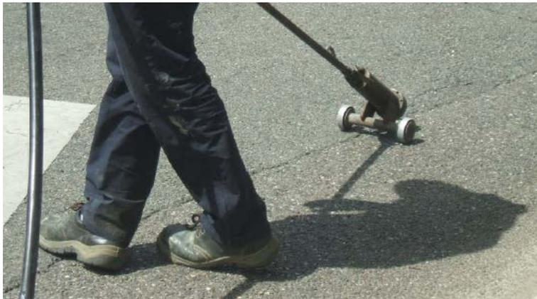
**Fig. VII. 2 : Chauffage et nettoyage de la fissure (Air sous haute pression : 400°C).
