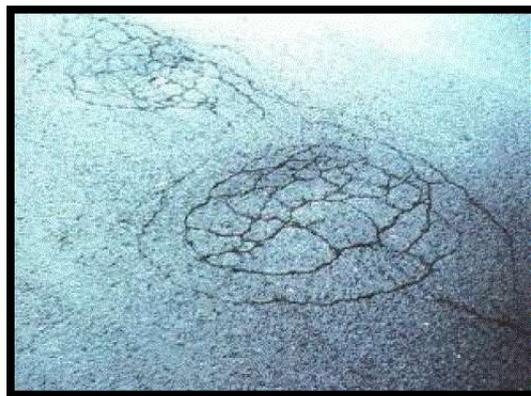
**Fig.III.15 : faïençage circulaire.** LCPC 1998
