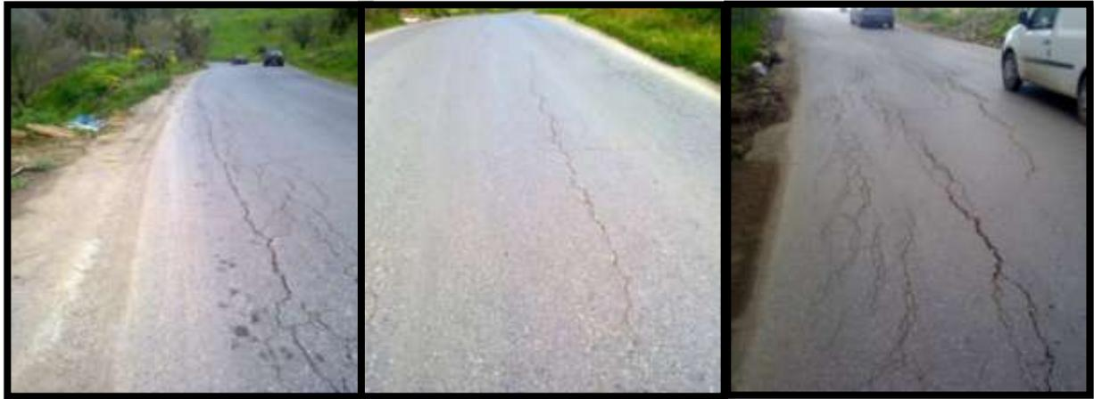
**Fig. III.31: Fissures longitudinales parallèles à l'axe de chaussée. RN 71 (IRSANE)**
