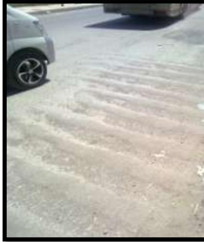
**Fig.III.39 :Les tôles ondulées. TIZI OUZOU**
