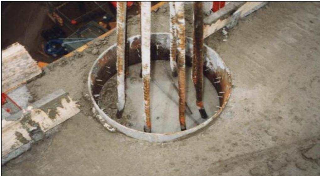
**Figure 8 : Poteau tubulaire avec clous tirés au pistolet comme connecteur de cisaillement et armatures sur chantier (Citibank Duisburg, Allemagne)**
