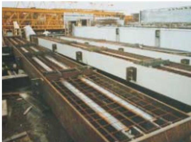
Figure 6 : Poteaux mixtes avec renforts soudés sur l'âme
