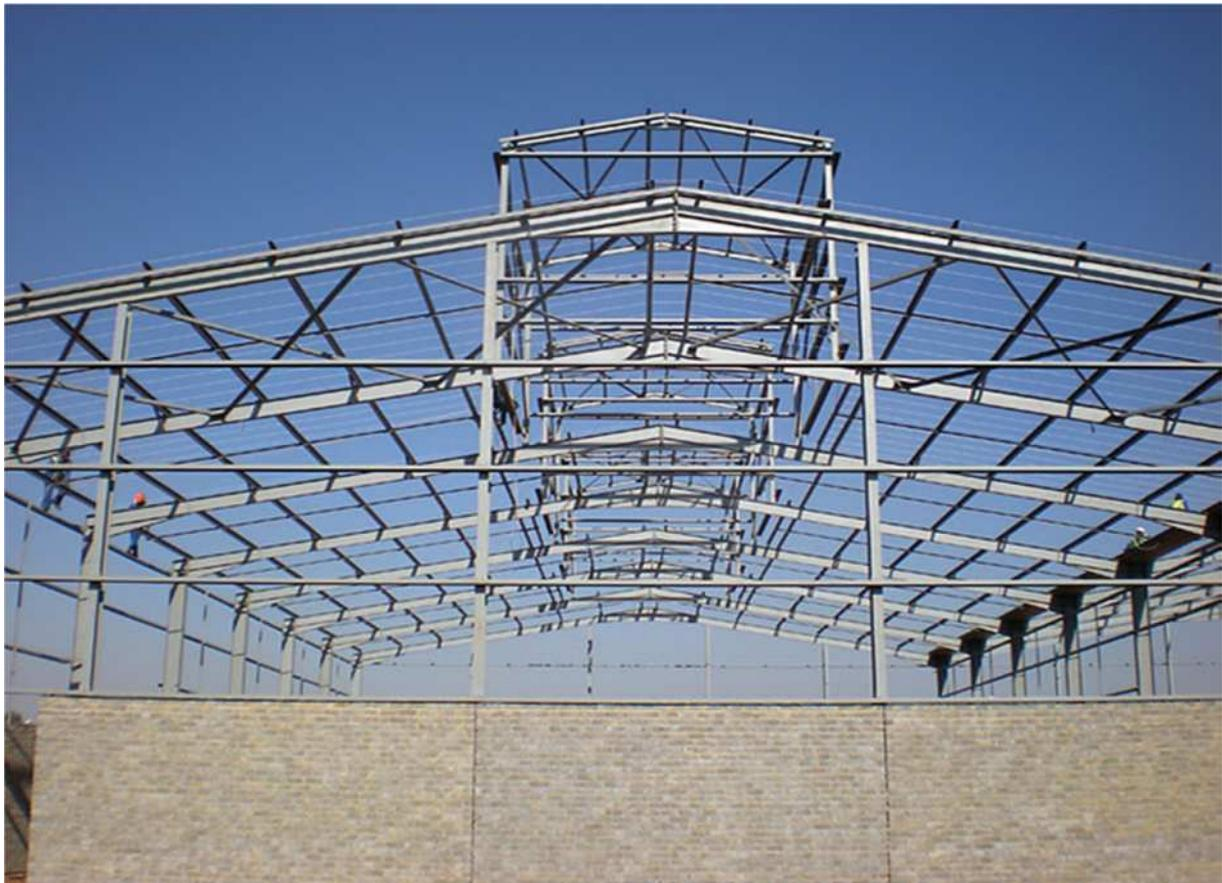
**Figure III.7** exemple de poteaux en acier HEA dans hangar
