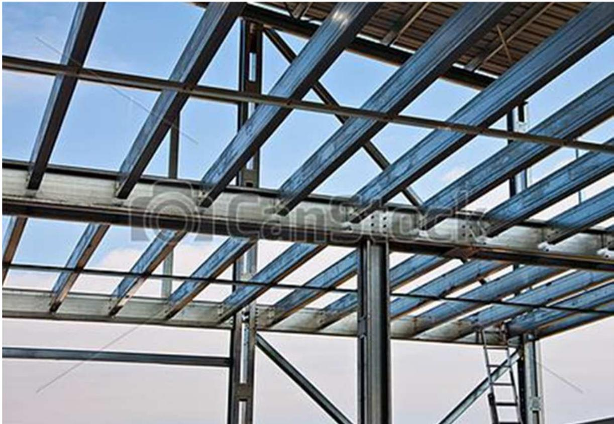
***Figure III.5*** exemple de poutres en acier IPE
