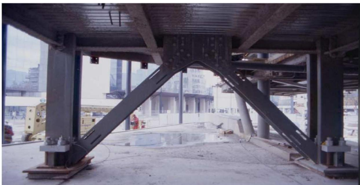
**FIGURE I.9** Exemple sur le contreventement en V
