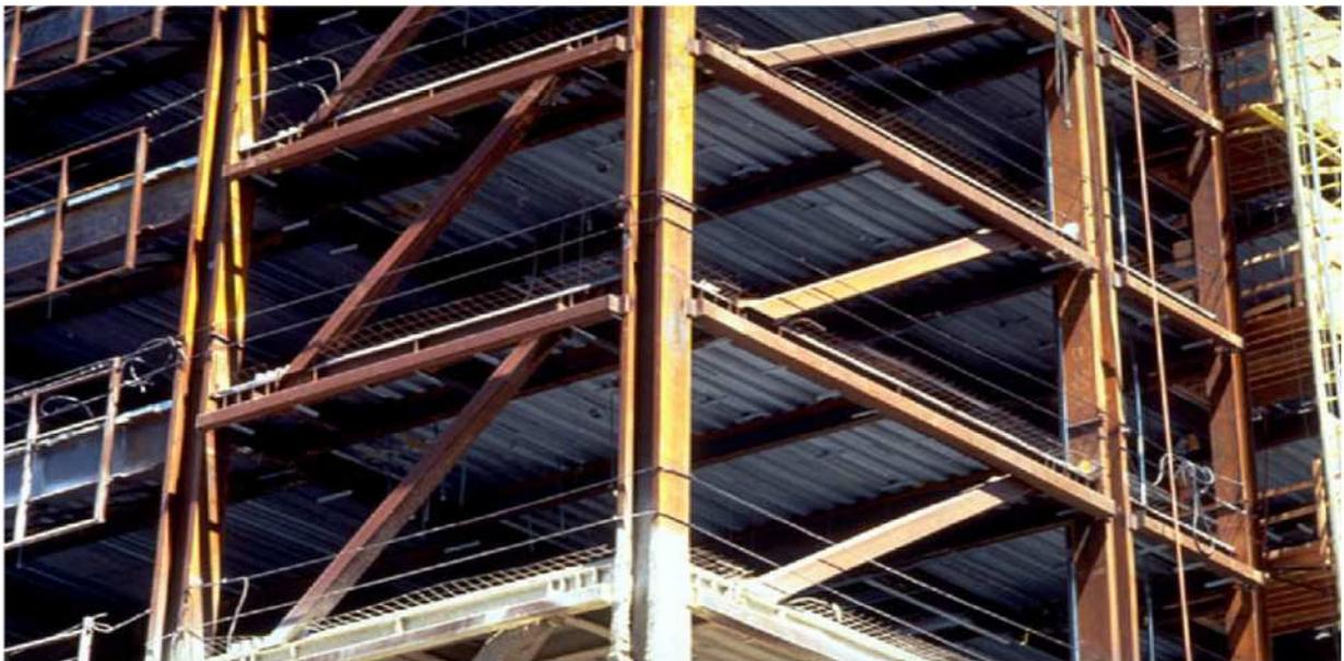
**Figure I.4** Ossatures avec triangulation à barres excentrées
