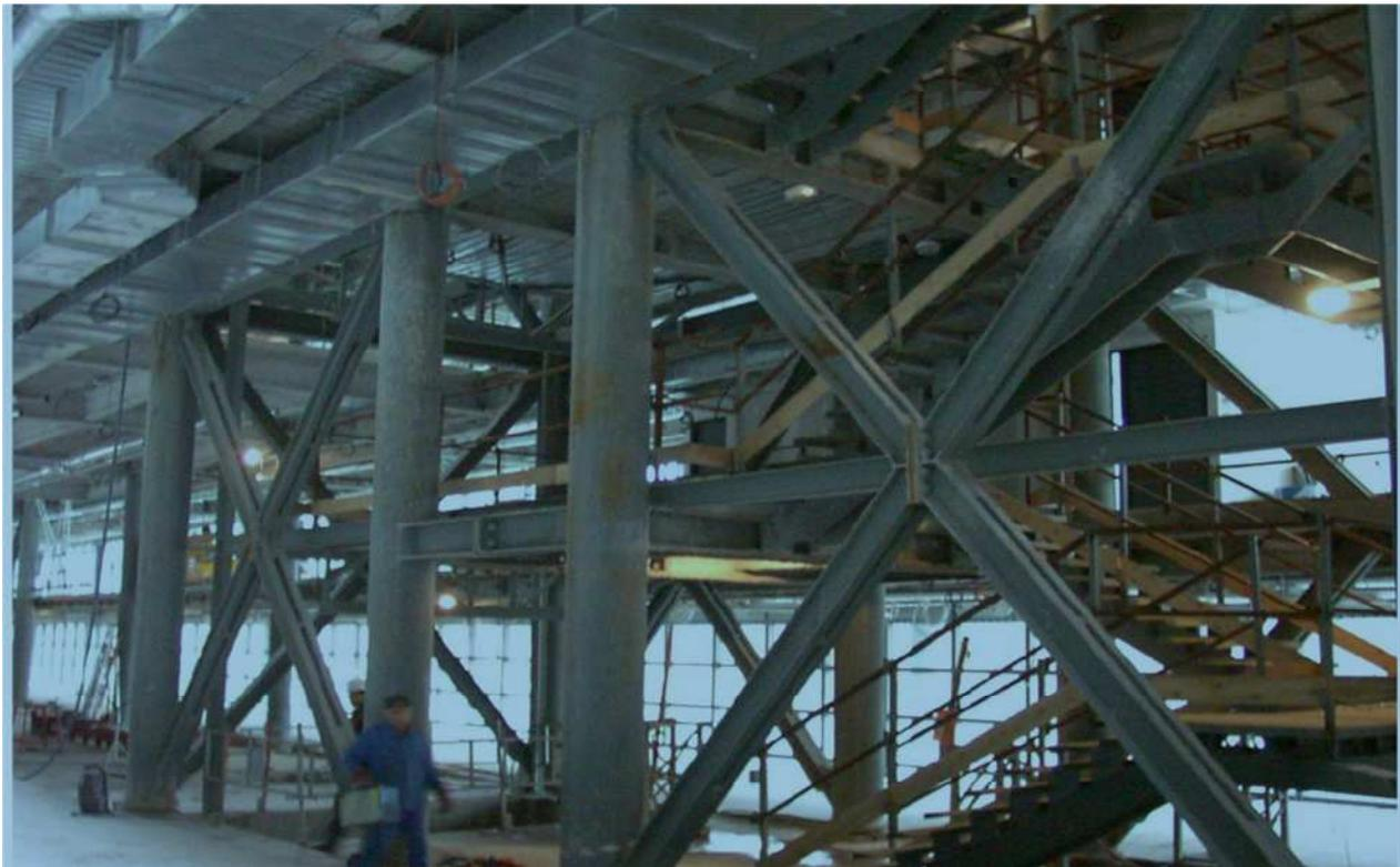
**Figure I.6** Exemple n°1 sur le contreventement en X
