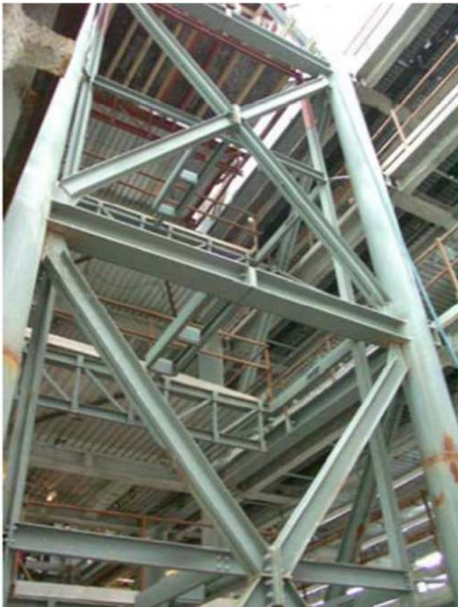
**Figure I.12** Liaisons rigides sur l'ossature principales et articulées, par faiblesse de la plaque d'assemblage qui peut plastifier rapidement, entre les barres des croix de Saint-André, et la structure principale.
