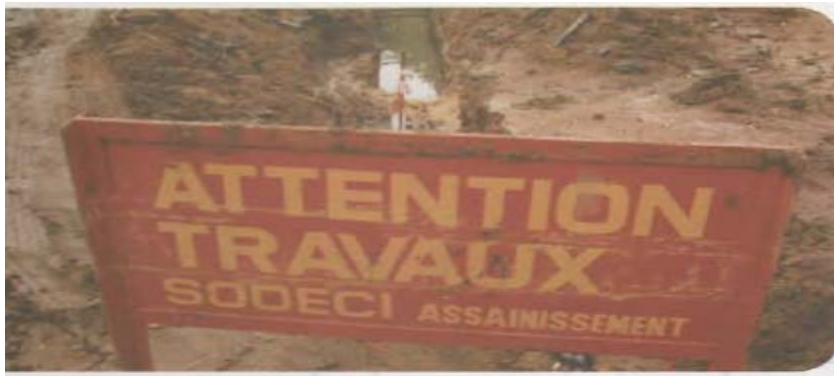
Figure 1 : Travaux d'assainissement de la ville d'Abidjan
