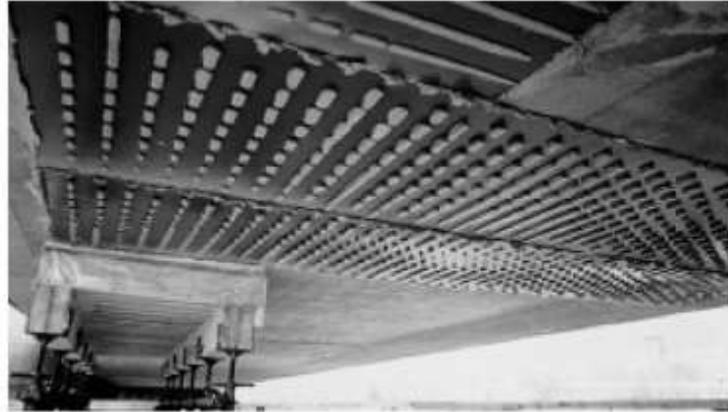
**Figure I-7 : Renforcement d'un viaduc par tôles collées**
