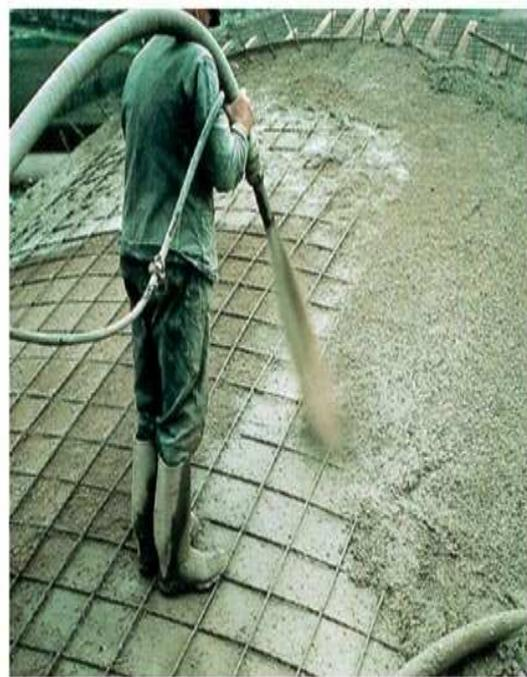
**Figure 2.10 :** Renforcement des murs de soutènement : Treillis soudés et béton projeté.
