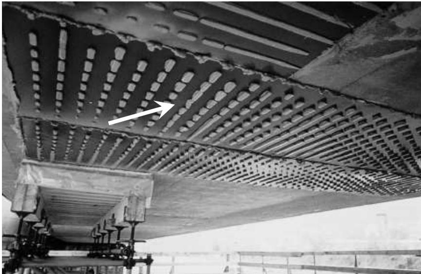
**Figure 2.8 :** *Tôles perforées en composites. (Réhabilitation des ouvrages d'arts : Freyssinet).*
