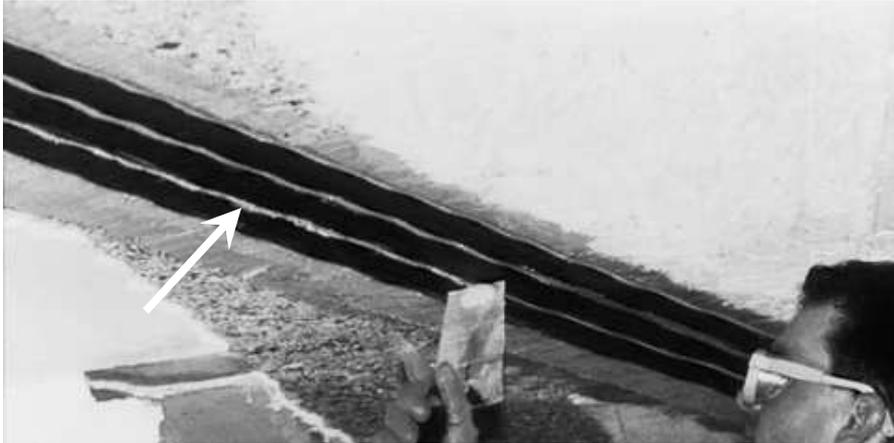
**Figure 2.7 :** *Renforcement d'une poutre par des bandes pultrudées.*
