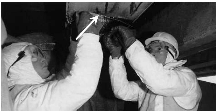
**Figure 2.13 :** *Mise en place du renforcement par des composites.*
