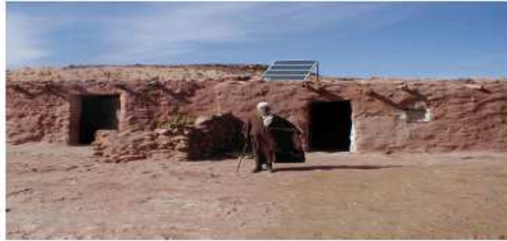
Fig- A.III.2: Solar Home System (SHS) de puissance 300 [Wc], installé à Moujbara wilaya de Djelfa
