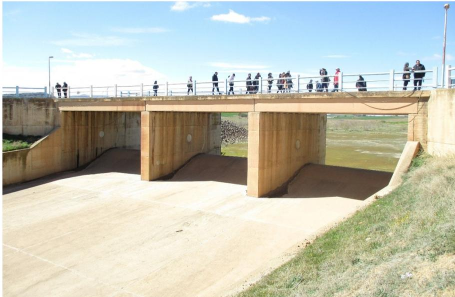
**Figure 4.** Vue de face de l'évacuateur de crue de type Creager et des piles (Photo CHA).
