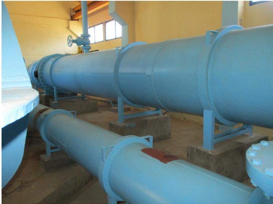
**Figure 9.** Arrivée des canalisations de prise à l'intérieur de la station de pompage
