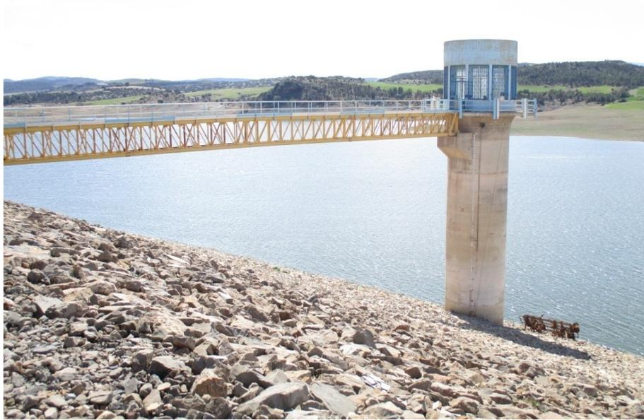
**Figure 7.** Tour de prise d'eau avec la règle limnométrique
