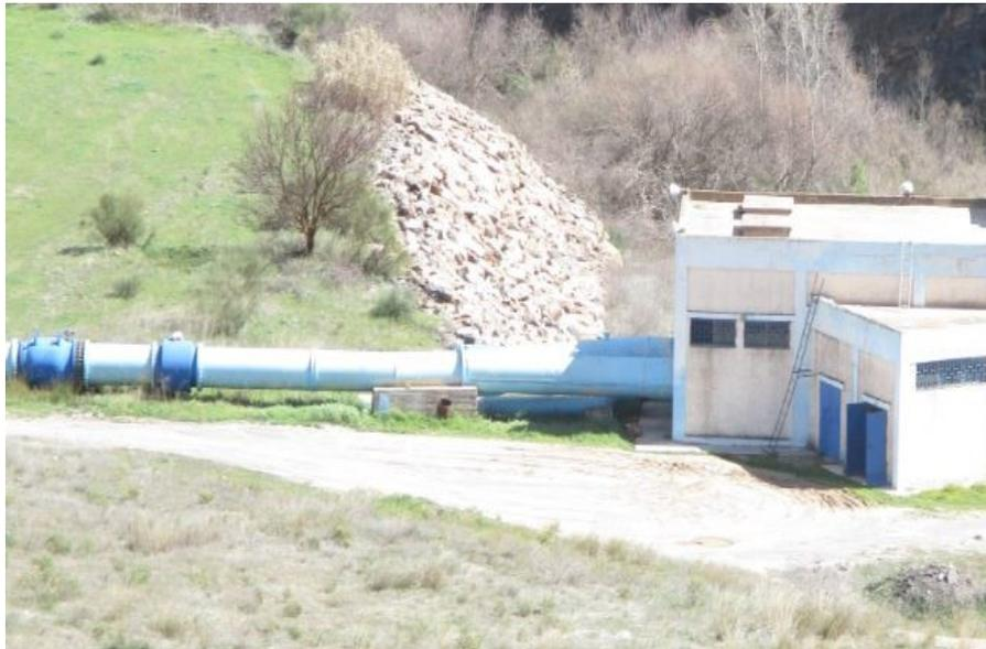
**Figure 10.** Vue de la station de pompage de l'ONID. Sortie des canalisations avec les diverses pièces hydrauliques (débitmètre, clapet anti-retour)
