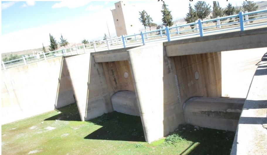
**Figure 5.** Vue amont de l'évacuateur de crue de type Creager et des piles (Photo CHA).
