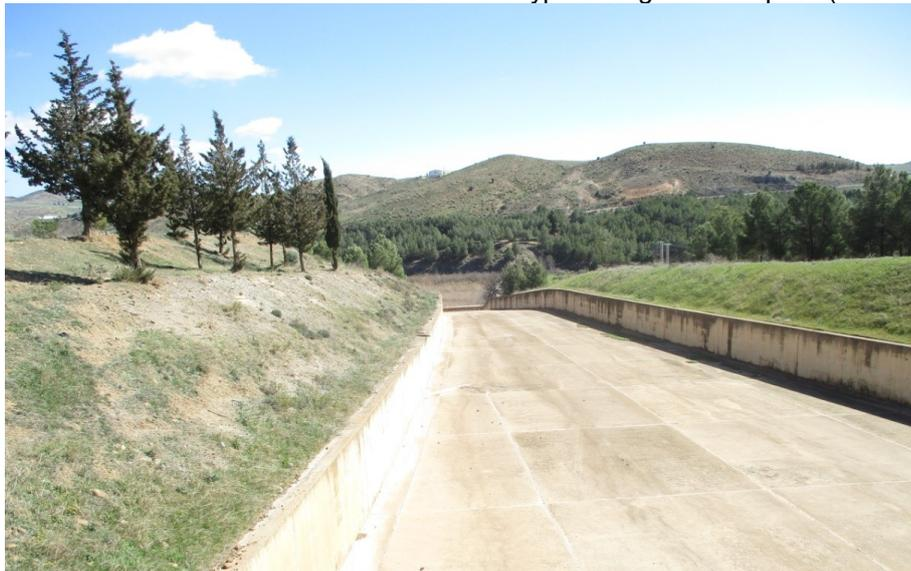
**Figure 6.** Vue du coursier de l'évacuateur de crue avec ses bajoyers (Photo CHA).
