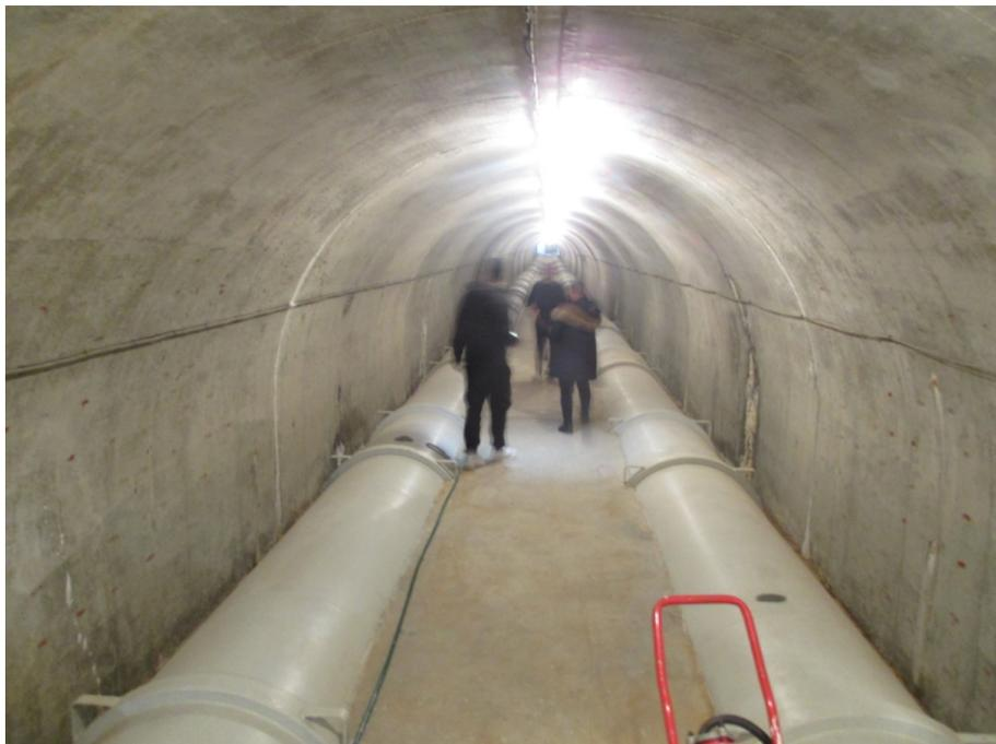
**Figure 8.** Galerie de dérivation avec les canalisations de distribution
