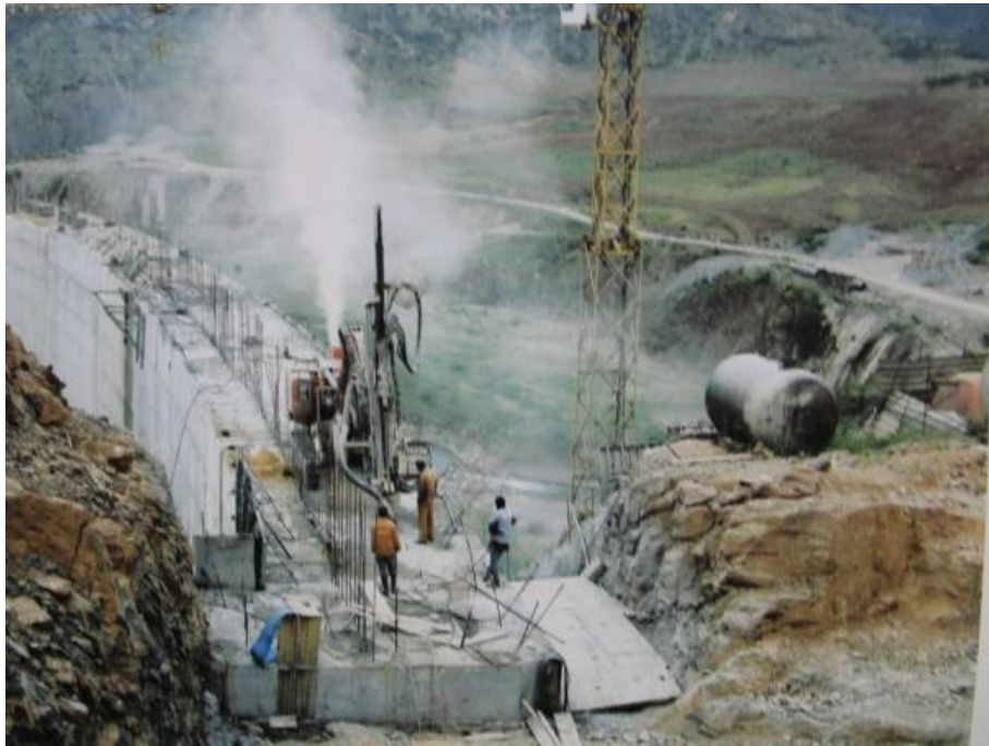
Figure 10. La digue voûte lors de la réalisation [photo ANBT].
