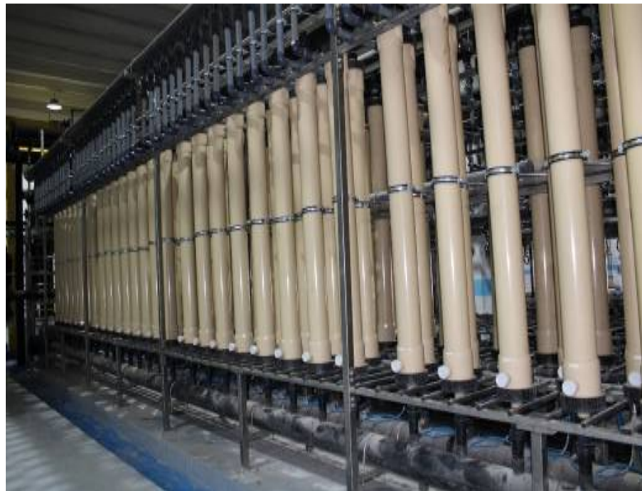
Figure 32. Vue des buses d'Ultrafiltration.
