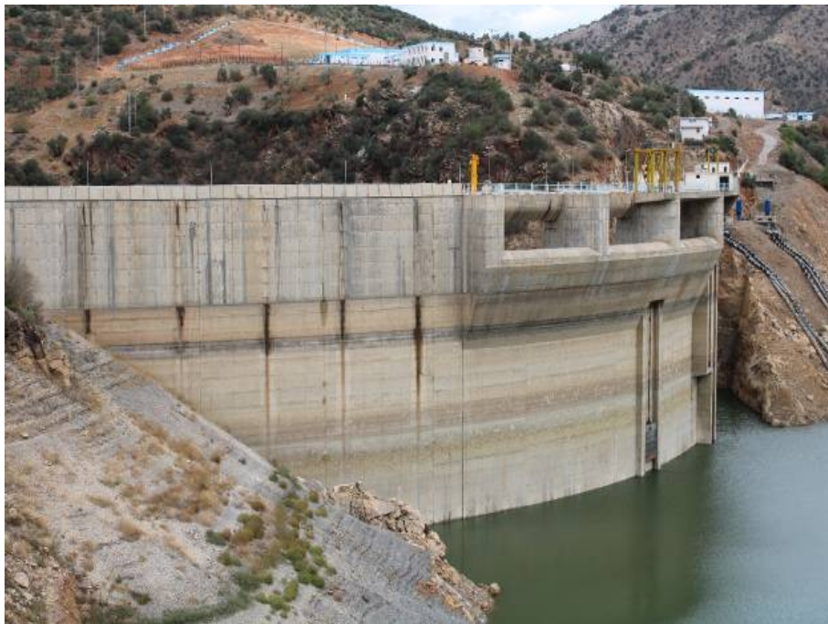
Figure 11. Digue secondaire du barrage, de type voûte – Vue amont [photo Lyes].
