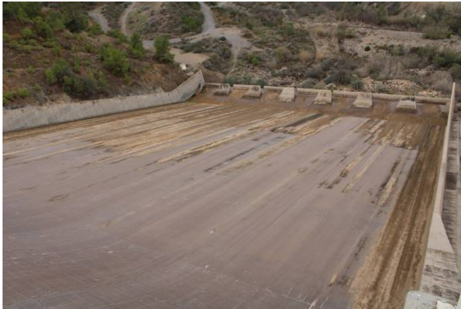
Figure 16. Coursier avec saut de ski au bout [photo Lyes].
