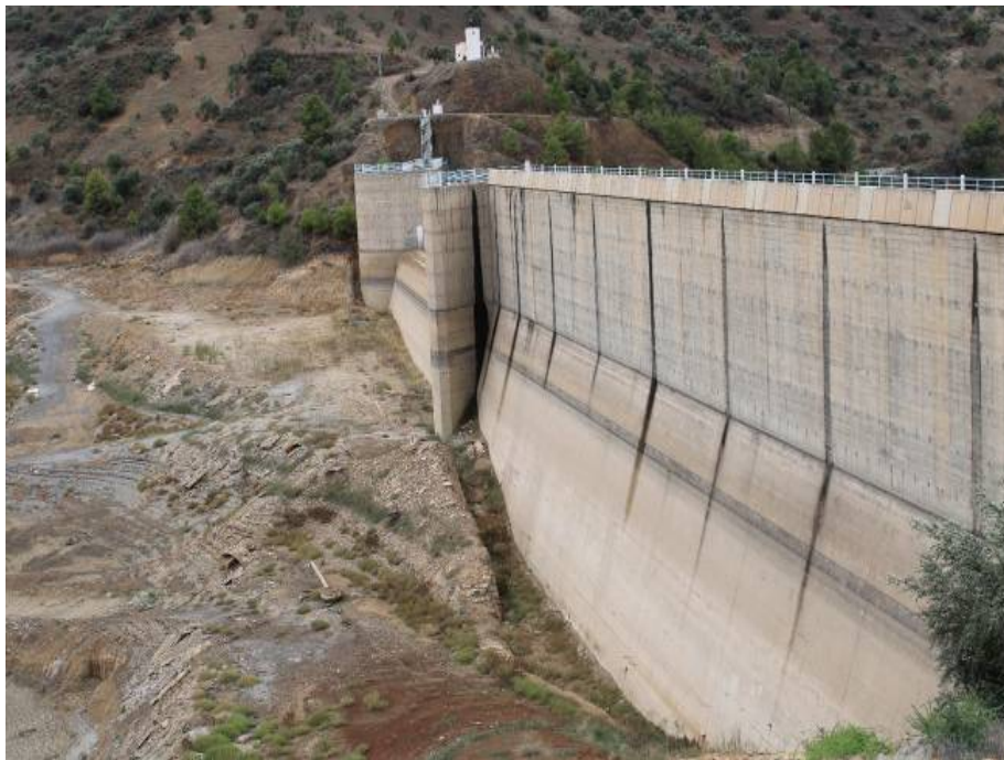
Figure 13. Digue principale du barrage poids, type Béton Compacté au Rouleau (BCR) – Vue amont [photo Lyes].
