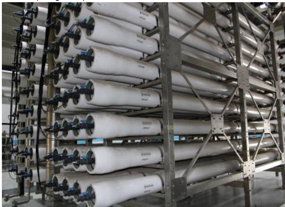
Figure 34. Système d'osmose inverse.
