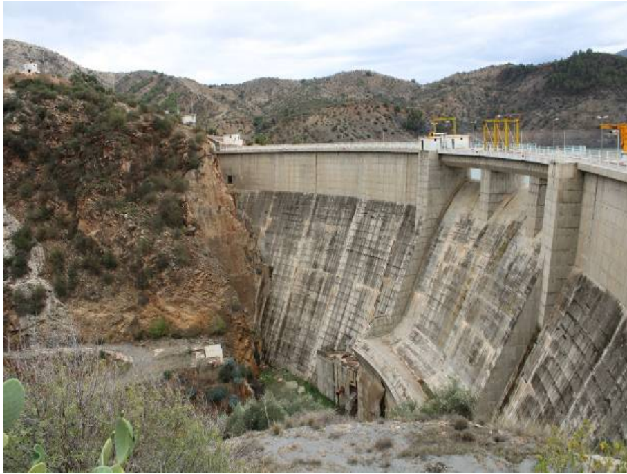
Figure 12. Digue secondaire du barrage, de type voûte – Vue aval [photo Lyes].
