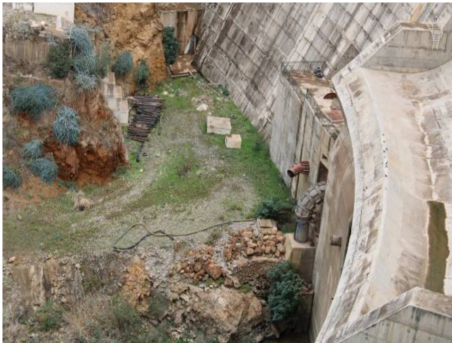
Figure 21. La conduite d'amenée à la station de traitement [photo Zerrouki].
