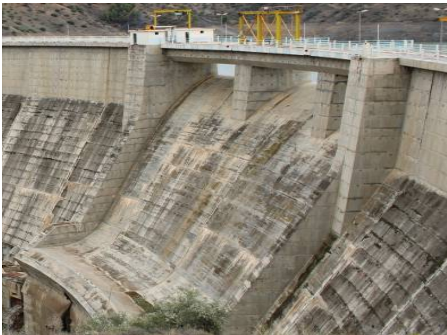
Figure 17. Évacuateur de crues secondaire à seuil libre incorporé au barrage voûte [photo Zerrouki].
