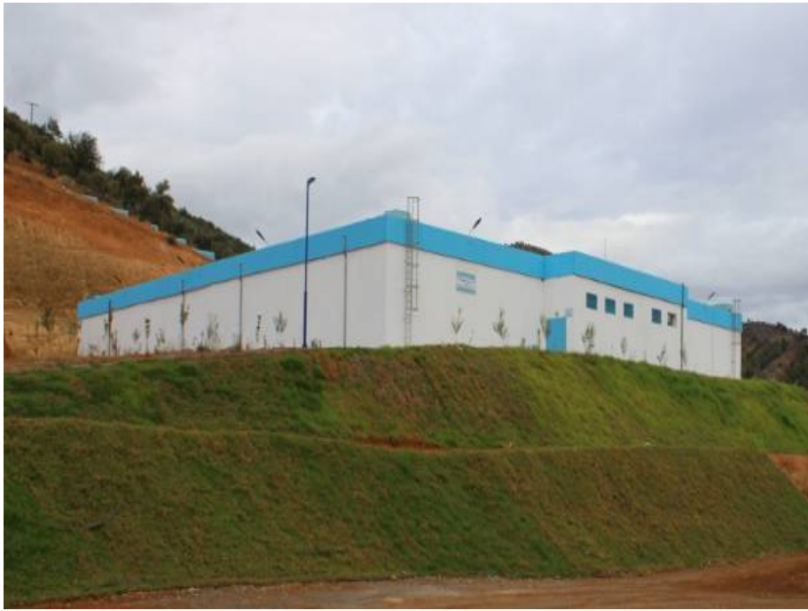
Figure 27. Réservoir des eaux brutes.
