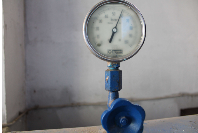
Figure 7. Manomètre sur la conduite de refoulement pour mesurer la pression (Photo Beldjerd).
