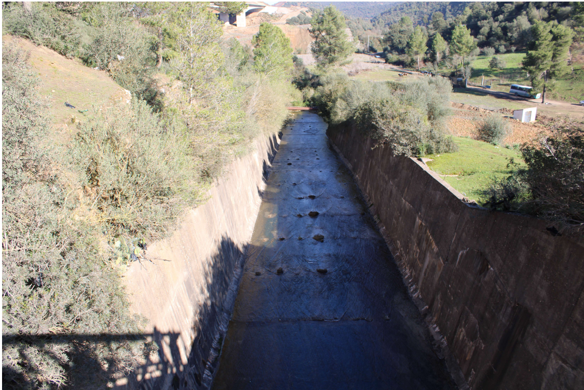
Figure 14. Vue du coursier de l'évacuateur des crues (Photo Beldjerd).
