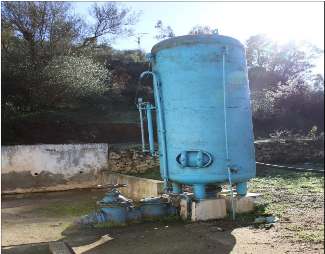
Figure 20. Ballon d'air anti-bélier (Photo Beldjerd).
