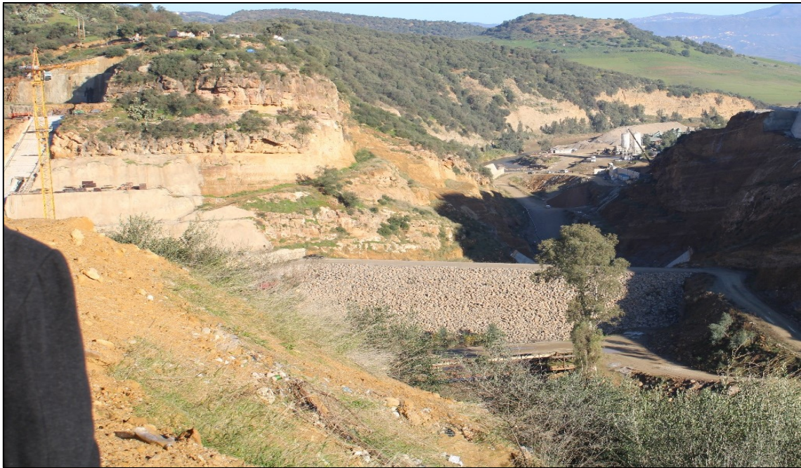
Figure 10. Vue du batardeau ou digue de dérivation (Photo Beldjerd).
