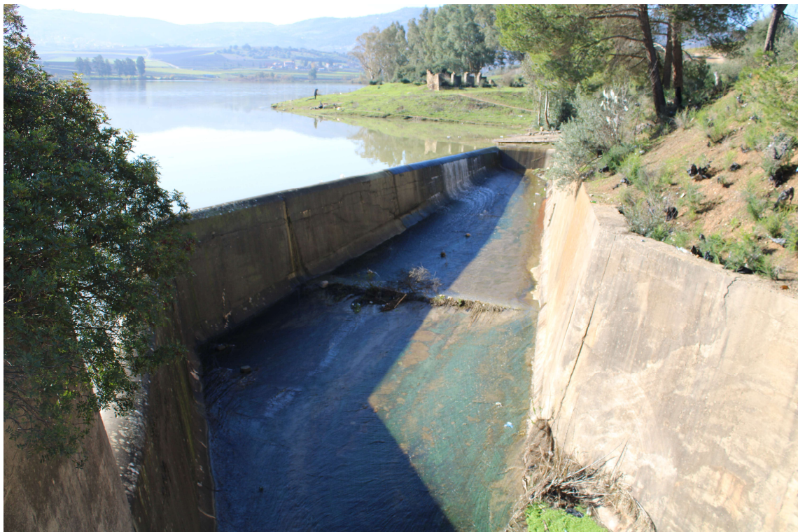
Figure 13. Vue du seuil déversoir de l'évacuateur des crues (Photo Beldjerd).
