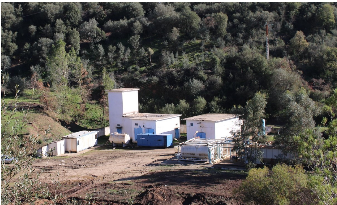
Figure 15. Vue d'ensemble de la station de traitement du barrage de DEM (Photo Beldjerd).
