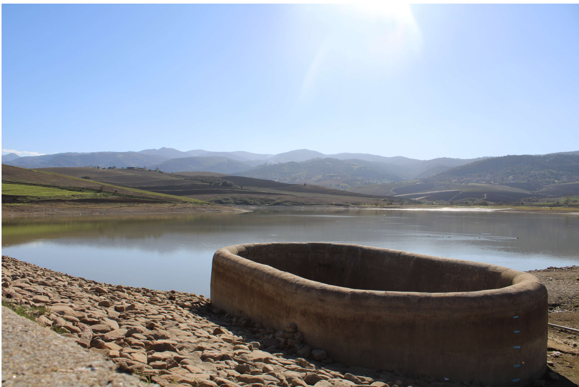
Figure 24. Evacuateur des crues lors de la visite du 13 Déc. 2021 (Photo Beldjerd).
