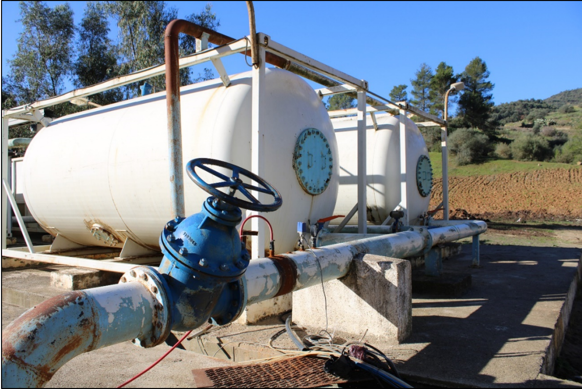
Figure 18. Les desableurs de la station de traitement en forme de citernes (Photo Beldjerd).
