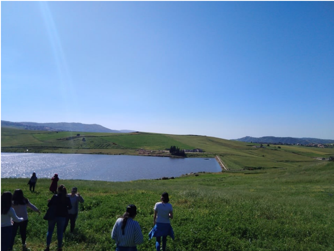
Figure 22. Vue d'ensemble du barrage Ain Zaouia - visite du 30 mai 2019 (Photo Hammoum).
