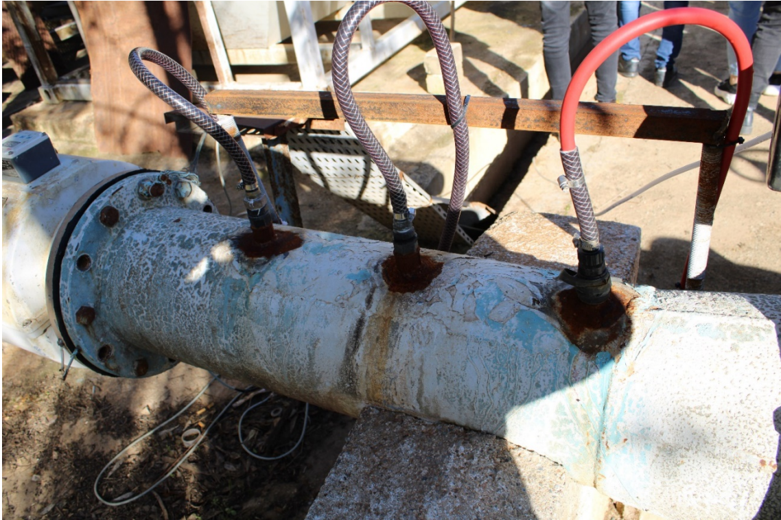
Figure 16. Injection des produits de traitement dans la conduite d'arrivée à la station de traitement (Photo Beldjerd).
