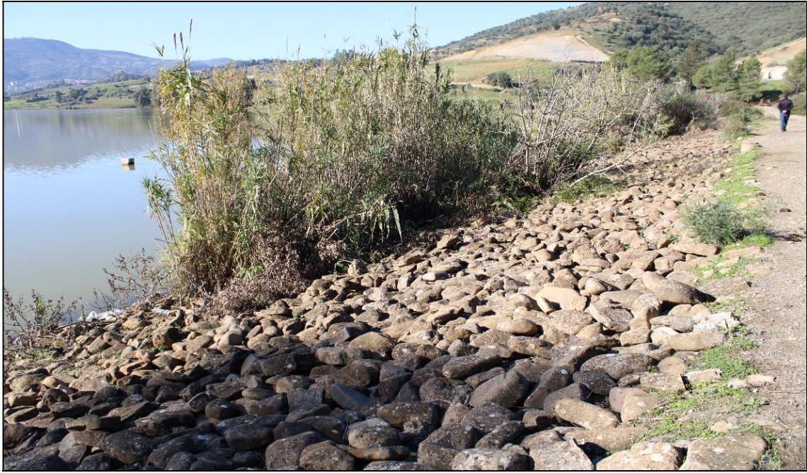
Figure 12. Vue de la protection en enrochement du talus amont de la digue (Photo Beldjerd).
