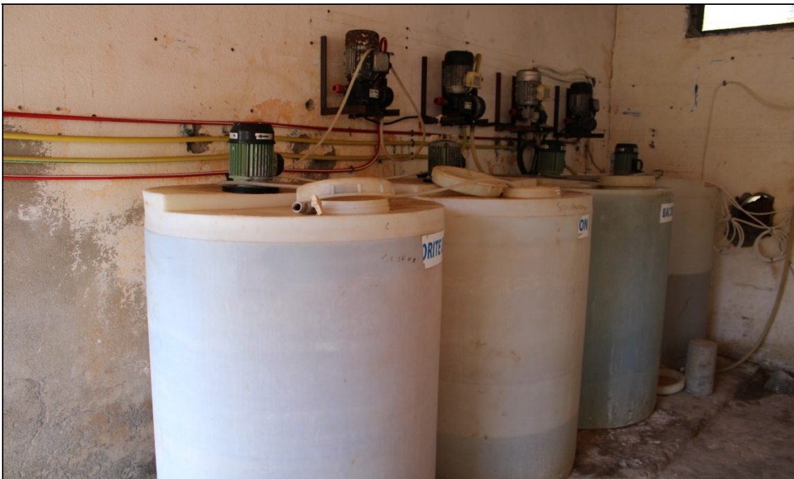
Figure 21. Réservoirs des produits de traitement (Photo Beldjerd).
