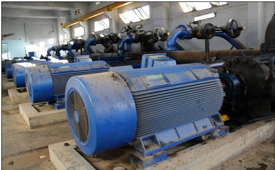
Figure 2. Groupes électropompes de la station Tassadort (Photo Beldjerd).
