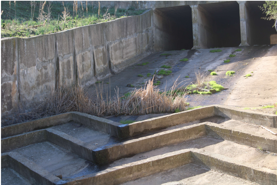
Figure 25. Vue du coursier avec des poutres posées en zigzag jouant le rôle de brises charges (Photo Beldjerd).
