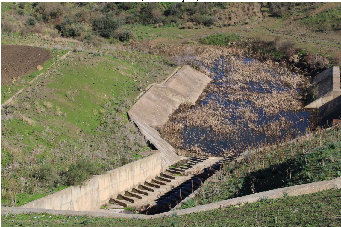
Figure 26. Bassin d'amortissement du barrage Ain Zaouia (Photo Beldjerd).
